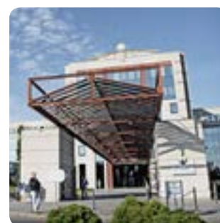
SIG Energieservices | CH
