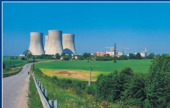
Elektrownia jądrowa – Temelín
