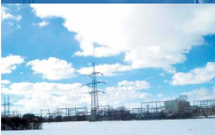
GPZ (Główny Punkt Zasilający)
