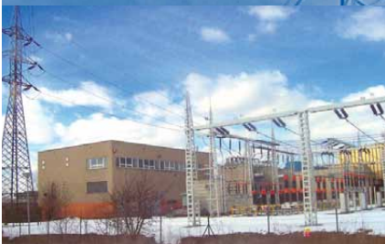
Stacja elektroenergetyczna 220 kV
