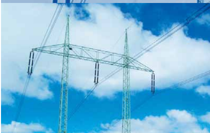
Linia elektroenergetyczna WN
