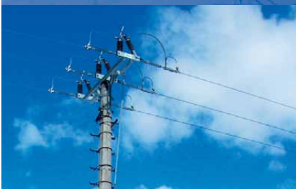
Linia elektroenergetyczna SN
