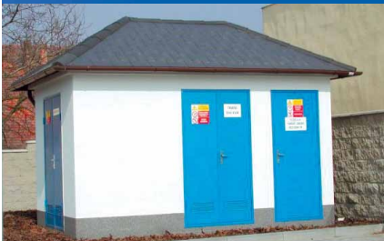
Stacja wewnętrzna SN/nN
