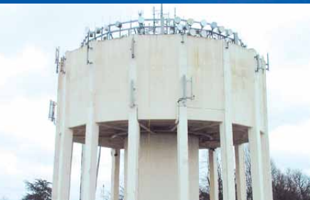
Zbiorniki wody uzdatnionej
