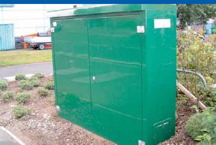
Stacje pomp podnoszących ciśnienie wody
