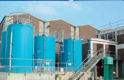
Stacje uzdatniania wody
